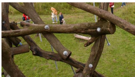
Figure 2 : bois solidarisés au moyen de tiges filetées - détail d'une réalisation de Polissky
