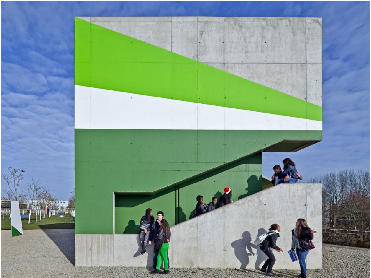
Figure 13. Vue de la façade sud du Kiosk de Kirchberg, projet de l'agence Polaris Luxembourg
