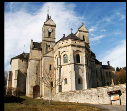
Fig. 10. Contre plongée de la façade Est
