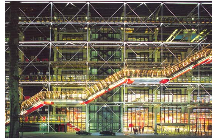
[Fig 3.1] Centre Pompidou à Paris
