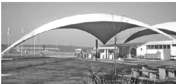
3. Station service à Deitingen sur l'autroute A1 Zurich-Bern par Heinz Isler, 1968. La maquette d'étude a permis de trouver la forme la plus adaptée à donner à la voûte en béton en fonction de la gravité.
