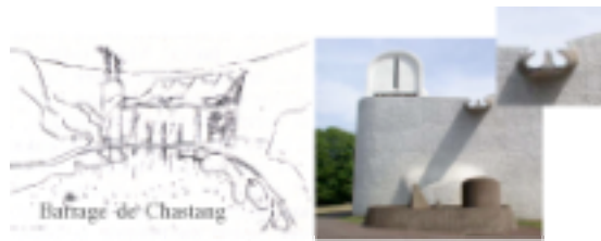
Figure 2. Le Corbusier, La chapelle de Ronchamp : par analogie à la forme du déversoir d'un barrage, Le Corbusier avait déterminé la forme des gargouilles par un changement d'échelle.
