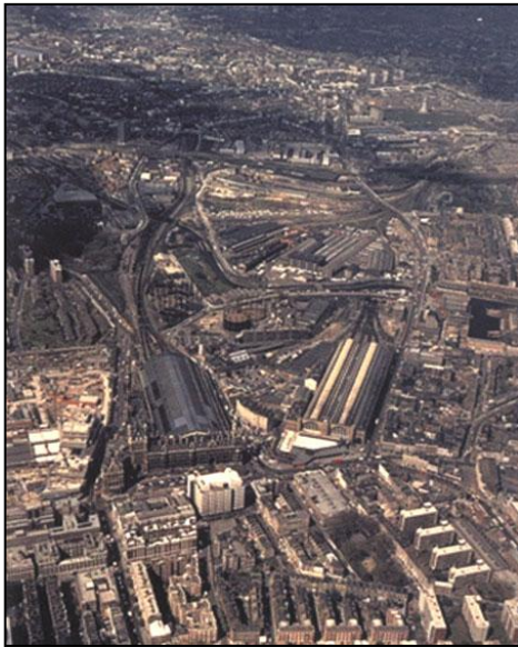
Fig. 13 : Vue aérienne du secteur de St Pancras et King's Cross
