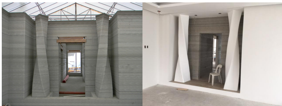
fig.34: Suite hôtelière indépendante intégralement imprimée en 3D aux Philippines, réalisée par Andrey Rudenko.
