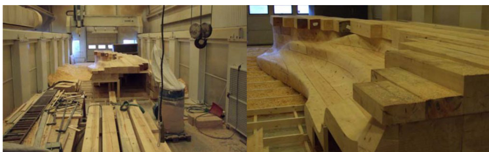
fig.46: Fabrication de la structure en bois, usinée dans des rondins de chêne à l'aide d'une fraiseuse cinq axes.
