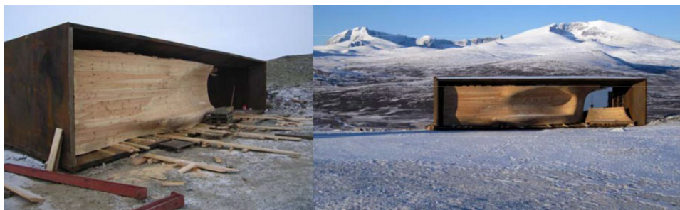
fig.47: Assemblage de la structure sur le chantier.
