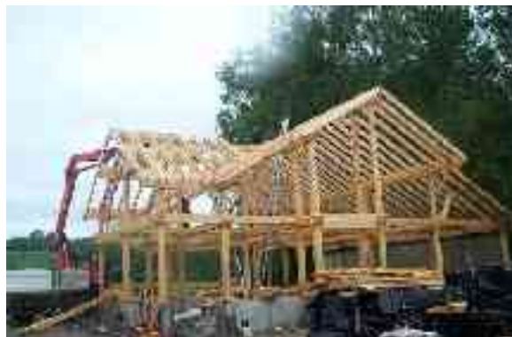
Figure 4 : La construction poteaux / poutres
