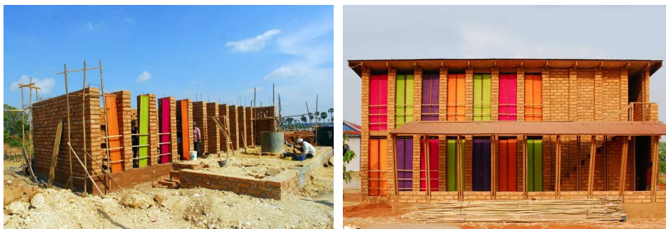
Figure 26 Chantier école de formation professionnelle (Cambodge) 2011
