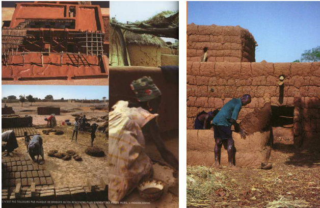
Figure 25 Chantiers, Afrique de l'Ouest
