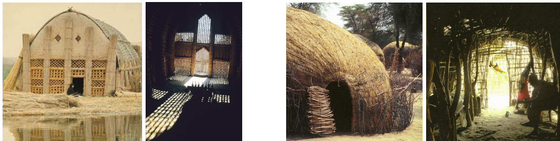
Figure 16 Maison en roseau (Irak), Maison Peul (Sénégal)
