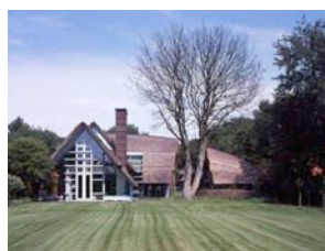
Figure 18 Maison construite autour d'un arbre
