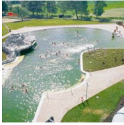
Figure 8 Piscine municipale Bad Königshoffen (Allemagne)
