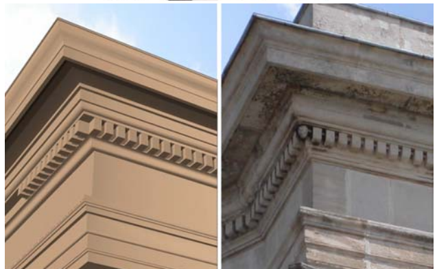
Figure 22 : rendu du modèle 3D de la corniche et photographie
