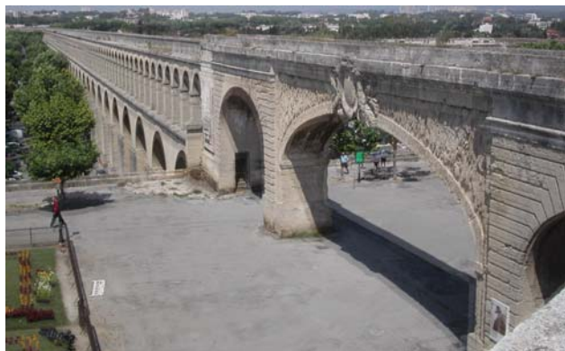
Figure 3 : l'aqueduc St Clément
