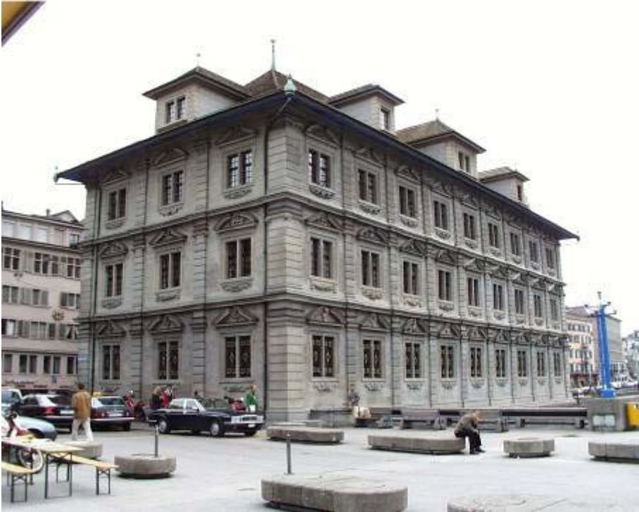
Vu depuis le pont
