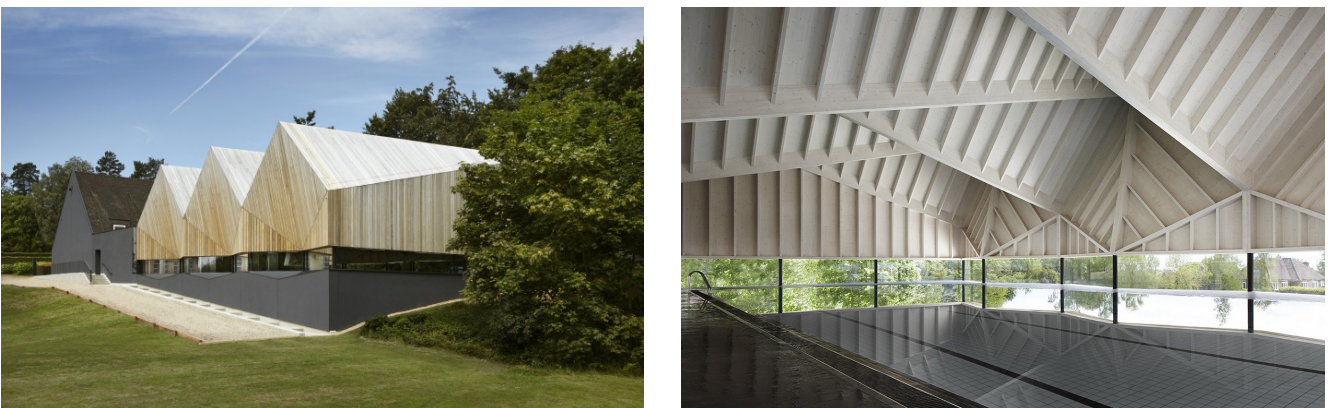
Figure 2.28 - Vue extérieure et vue intérieure de la piscine d'Alfriston School. La morphologie du plissage ainsi que les montants visibles des composants favorisent l'absorption du son. D'après (Hobhouse, 2015).
