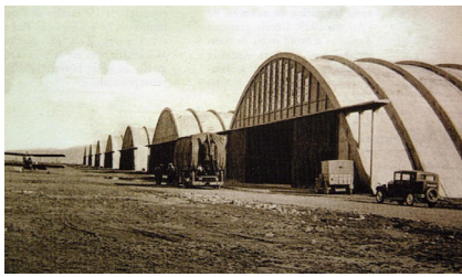
Figure 1.41 - Voûte nervurée des hangars de la base militaire d'Avord et Istres.
