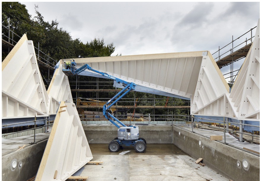
Figure 2.11 - Montage des panneaux à ossature formant la coque plissée qui recouvre la piscine. D'après (Hobhouse, 2015).
