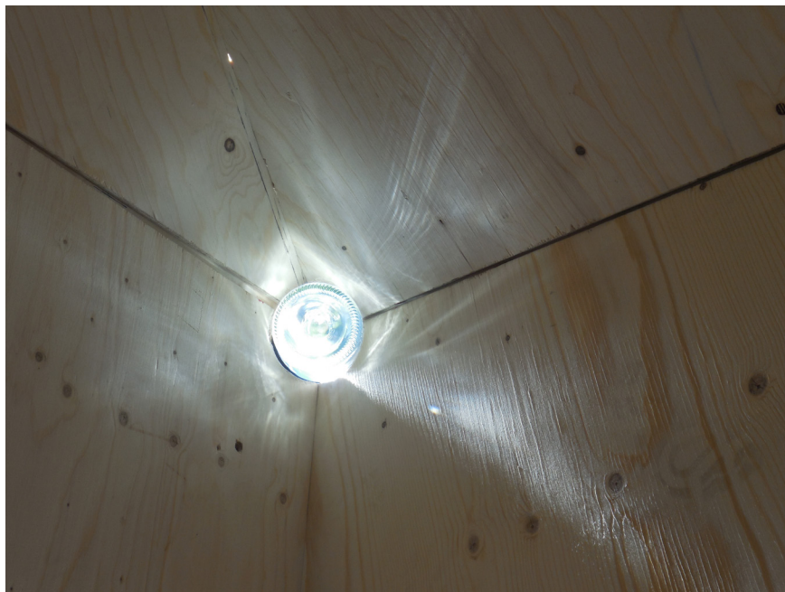
Figure 6.23 - Diffusion de la lumière par les nœuds à l'intérieur de l'enveloppe plissée (perçement comblé par une bouteille de verre remplie d'eau). Détail de la New-Yourte, Défis du bois 2014.
