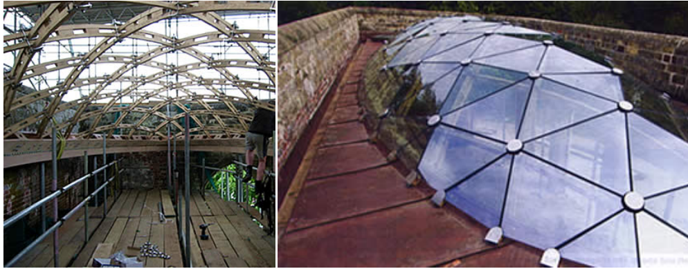
Figure 36 : Orangerie de Chiddingfold, résille bidirectionnelle recouverte de facettes en verre, source : www.carpenteroakandwoodland.com , arch. Peter Hulbert
