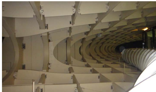
Figure 5 : Vue depuis l'intérieur de la résille, source : D. Monier
