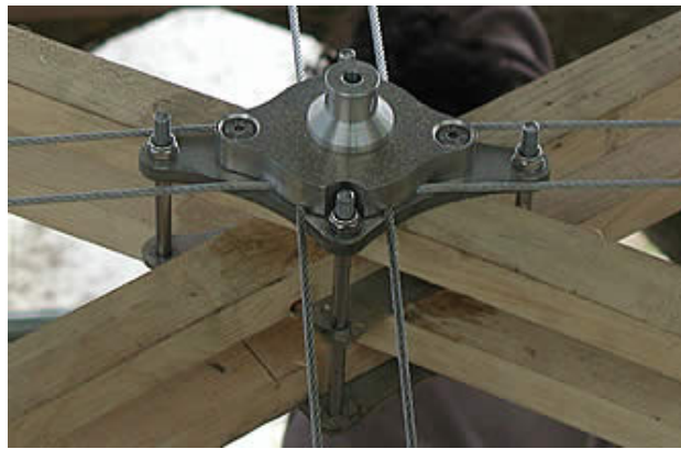
Figure 26 : système de liaison adaptable à des éléments de ressource, source : Orangerie de Chiddington
