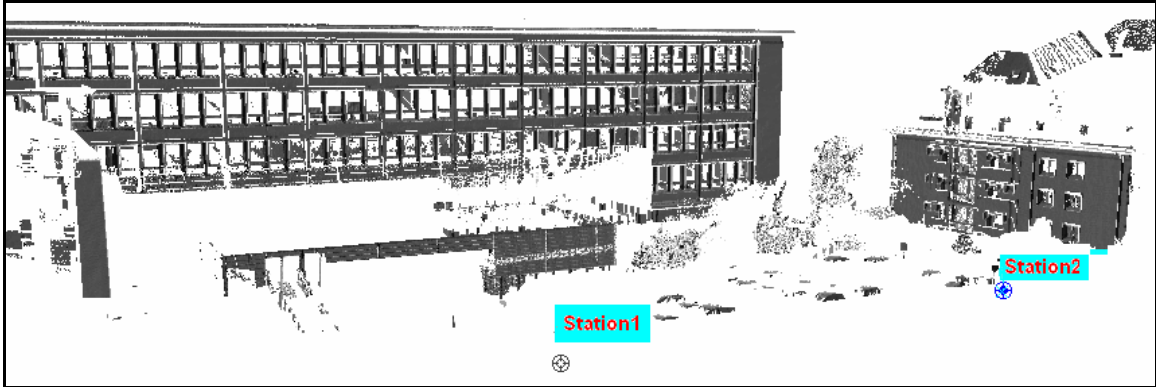
Figure 4.11 les deux origines des scans issus de la consolidation
