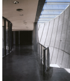
Figure 7 : éclairage zénithal, verrière
