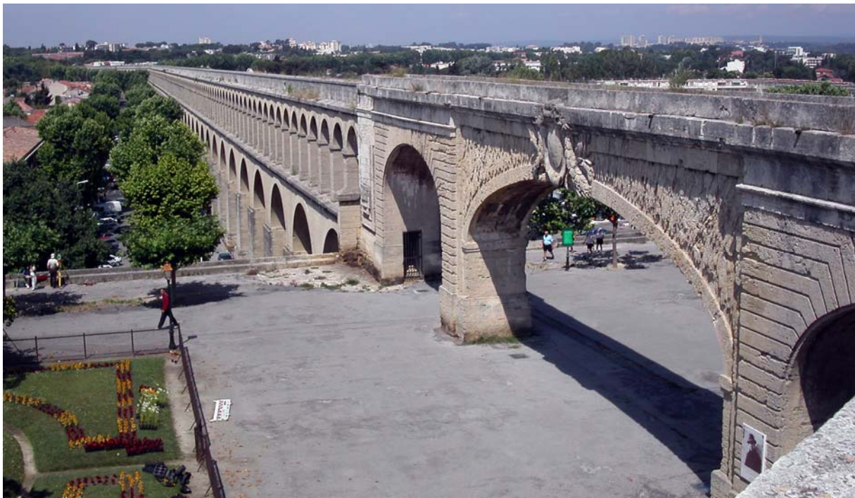
Figure 4-14 : L'aqueduc Saint Clément.
