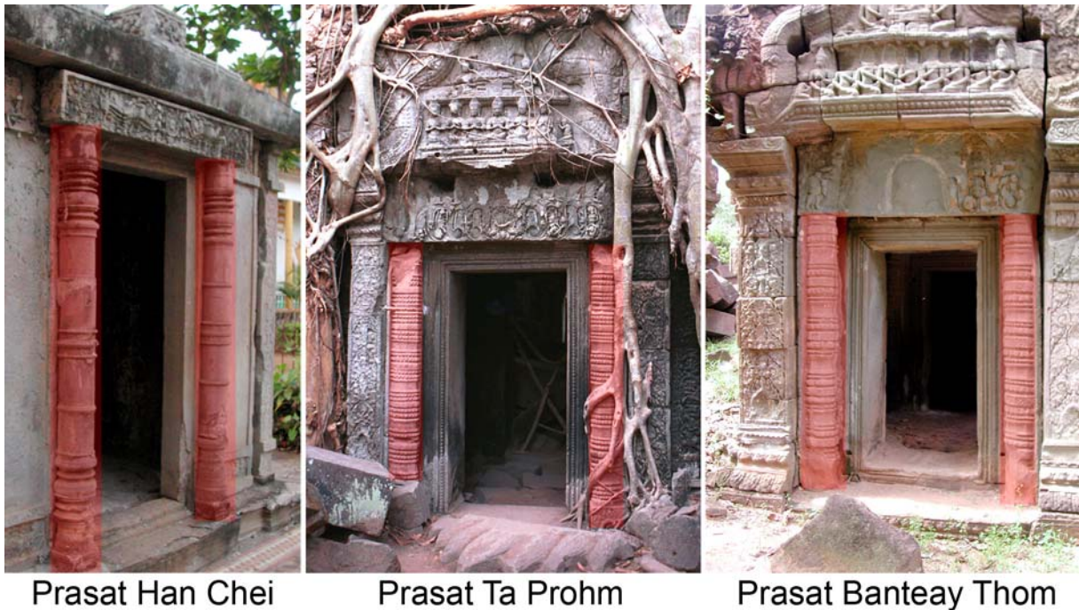
Figure 4-48 : Position de différentes colonnettes au niveau de l'accès des temples khmers (photographies: O. Cunin).
