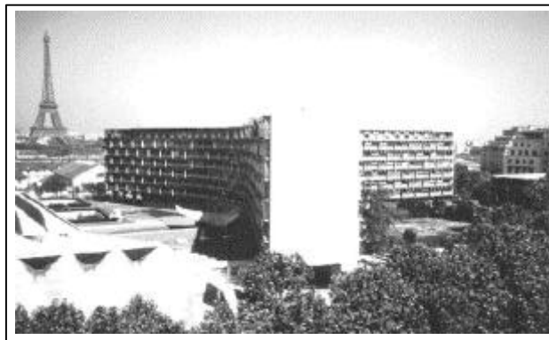
Figure 6 – Bâtiment de l'UNESCO (1953)
