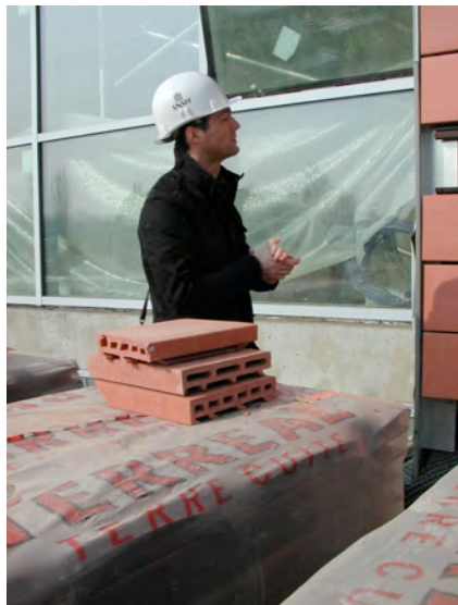
Les deux types de bardage : à 2 parois pour les parties courantes et renforcé pour les parties basses.
