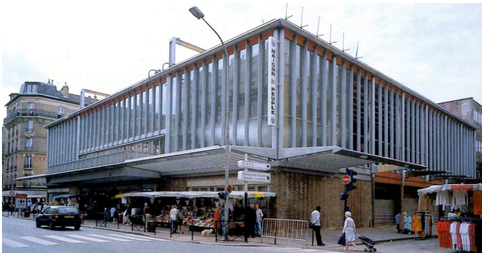
Photo N° 26 : Maison du peuple à Clichy. 1935-1939 . Etat en 1998 pendant la restauration. Fabrication du mur rideau par les Ateliers Jean Prouvé. Architecte : Marcel Lods. (in Sulzer, 2000)
