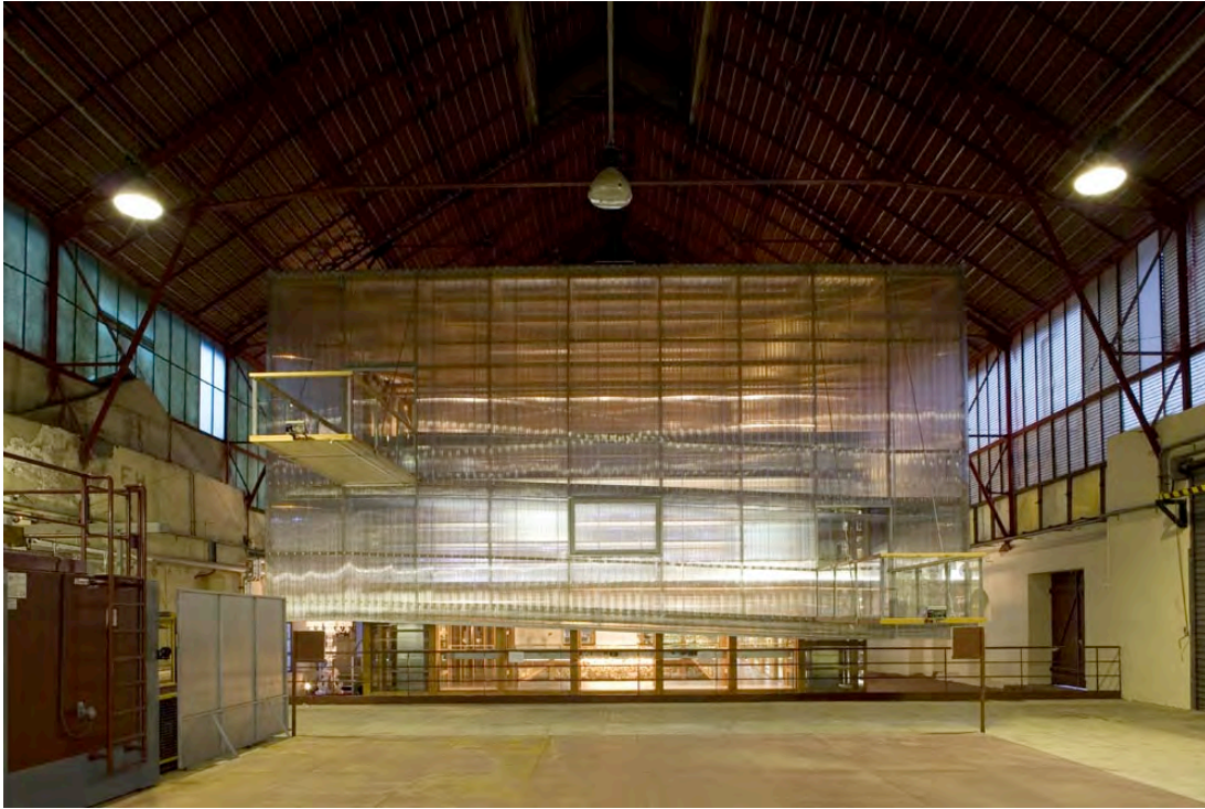
Façade intérieure du musée du cristal St Louis en polycarbonate . Lipsky-Rollet, architectes. Document fourni par l'architecte
