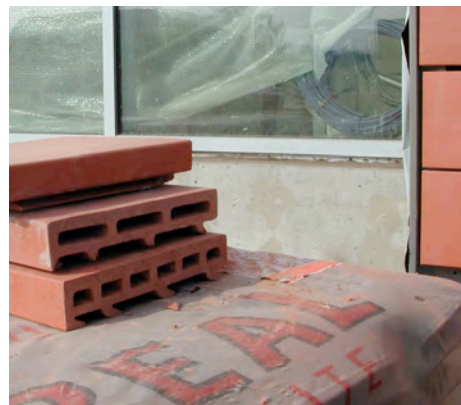
Mise en œuvre du bardage en terre cuite. Terreal
