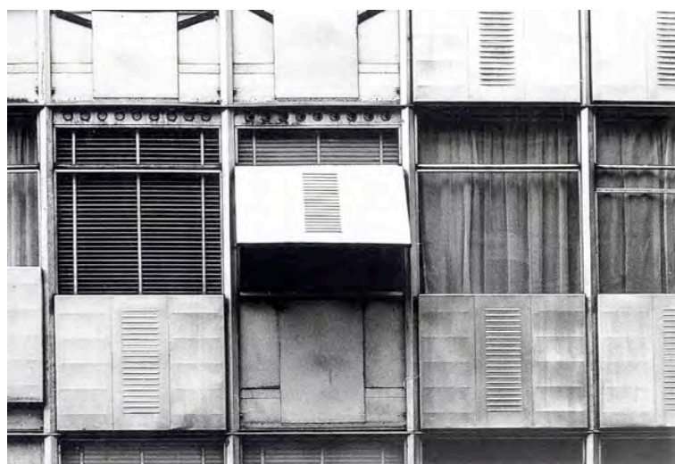
Photo N°27 : Immeuble d'habitation square Mozart à Paris. Façade fabriquée par les Ateliers Jean Prouvé (1953,1954). « Les panneaux de façade complexes préfabriqués à l'usine constituent à la fois l'allège, la fenêtre à guillotine, (équilibre caché), l'imposte, l'aérateur et le volet » (in Sulzer, 2005)
