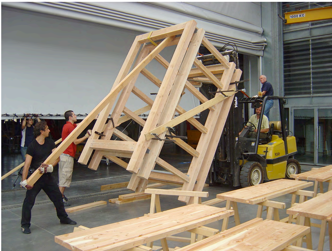
Expérimentation à échelle 1 aux Grands Ateliers de l'Isle d'Abeau. Construction du prototype. Lipsky-Rollet architectes. Document fourni par l'architecte.
