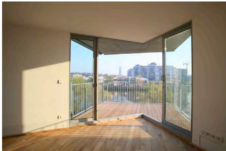
Châssis coulissant sur l'angle. Opération de logements à Nantes.
