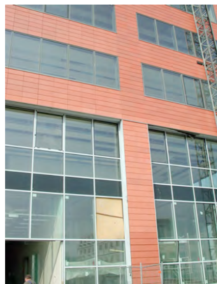
Cité du Millénaire à Aubervilliers. Arte Charpentier, architectes. Un bardage aux dimensions coordonnées avec les menuiseries. (Chantier Terreal ; photo N. Hoyet)
