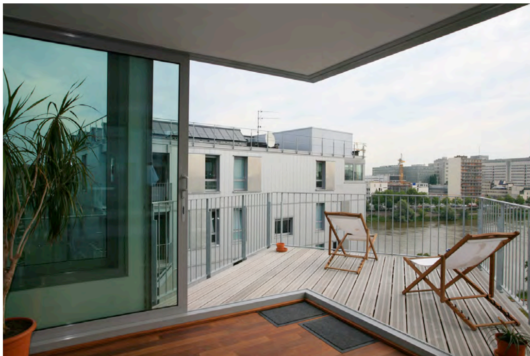
Photo N°14 : Logement à Nantes : détail de la fenêtre coulissante dégagée du montant sur l'angle. ANMA, architectes (document fourni par l'architecte).
