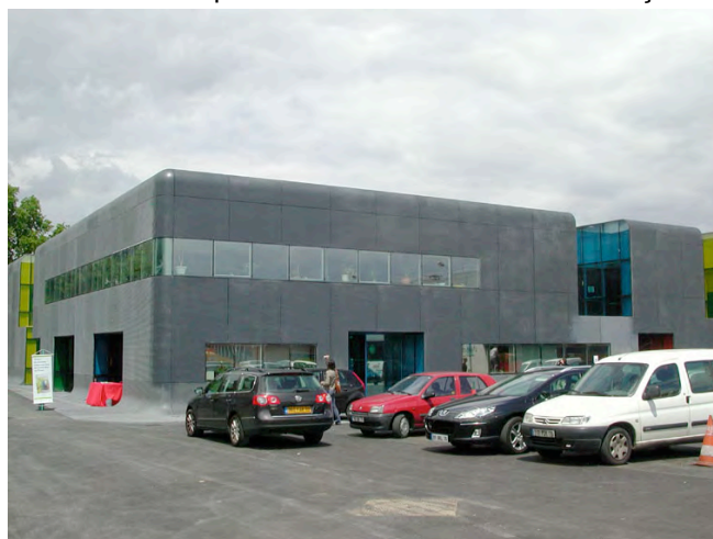
Dépôt pour la RATP à Thiais. Continuité entre sol du parking et façade Combarel et Marrec, architectes. (Photo N.Hoyet - mars 2007)
