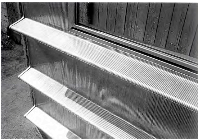
Photos N° 7 et 8. Conception d'un panneau de façade à voiles multiples. Dessin et prototype. (in Sulzer 2005)
