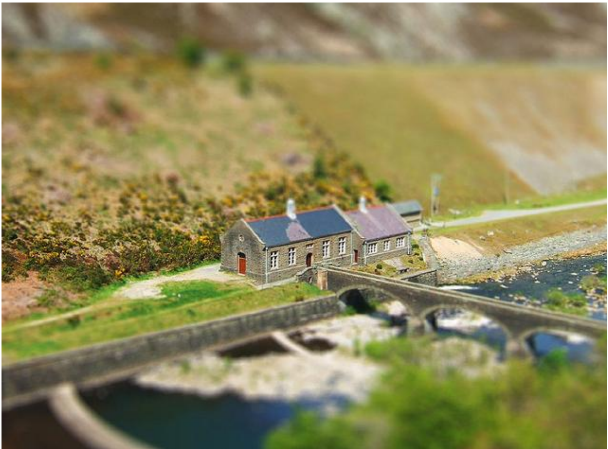
Figure 3. Photographie d'un bâtiment abritant des turbines au pied du barrage de Caban Coch, Pays de Galle. Photo : Frosted Peppercorn / flickr.com
